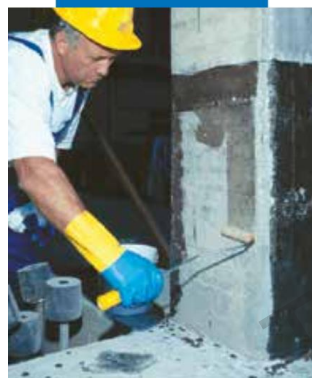
Полагане на слой MapeWrap Primer 1
