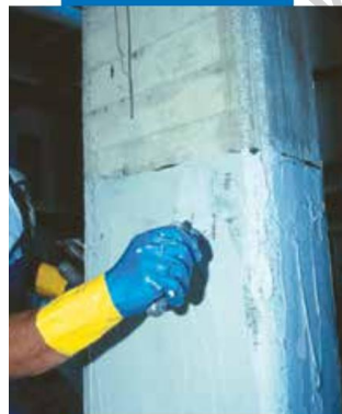
Подравняване с MapeWrap 11 или MapeWrap 12
